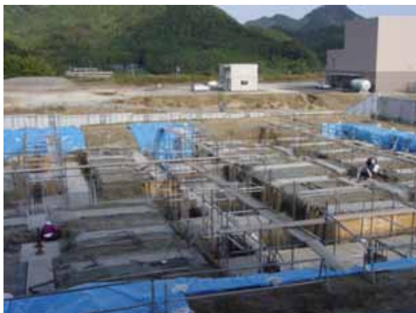
図1 建設中の水素利用技術研究センター(平成17年11月15日撮影)
