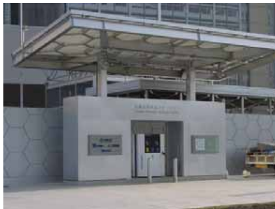
図4 水素ステーション実証試験設備
